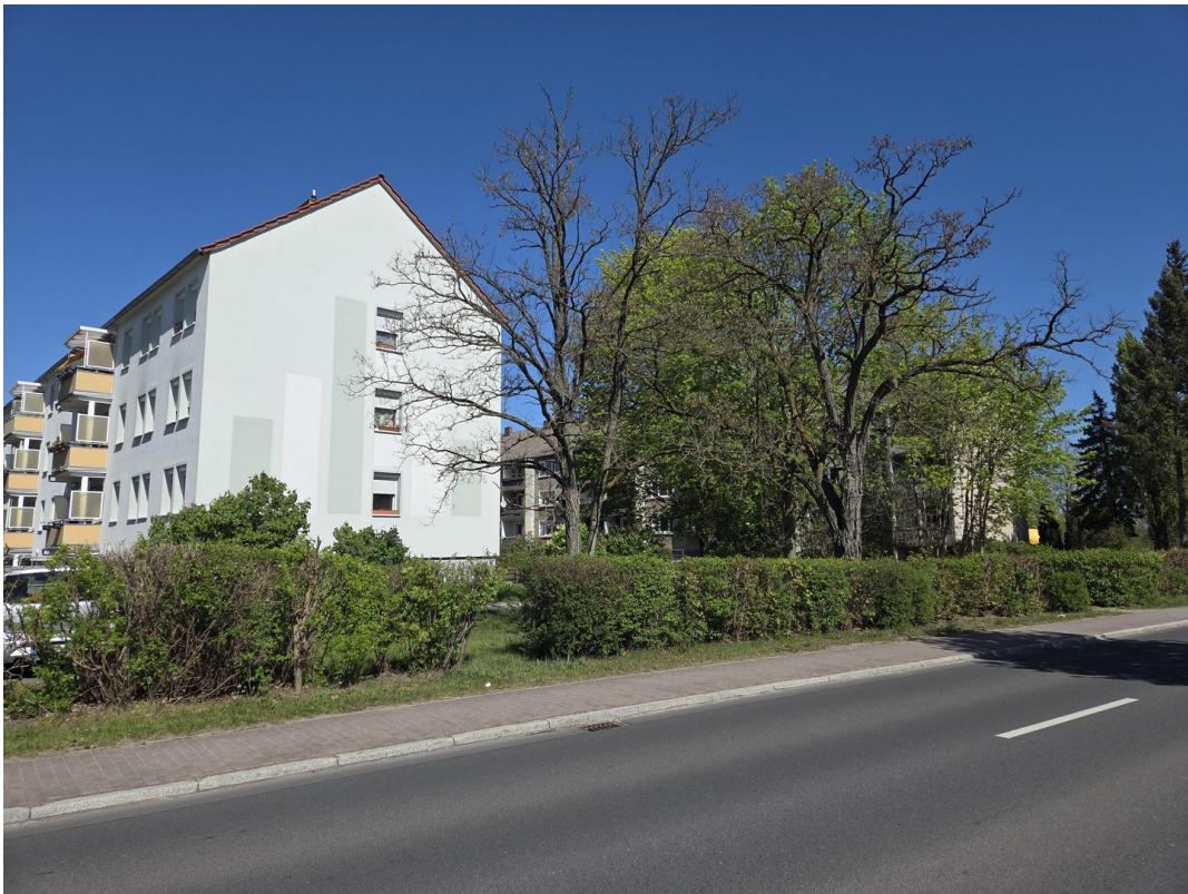
saniertes Block neben dem MFH
