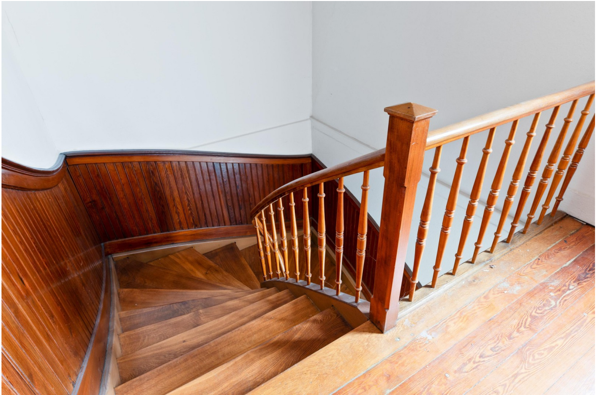
gepflegtes, schönes Treppenhaus
