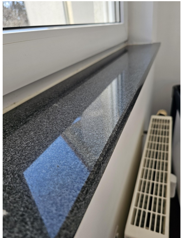
Fensterbänke aus Granit
