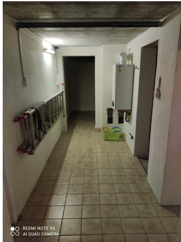
Flur Keller mit Therme
