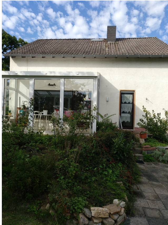
Haus-Südseite mit Wintergaren
