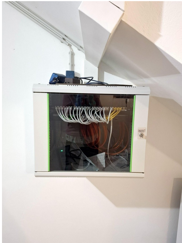
LAN-Verteilerkasten
