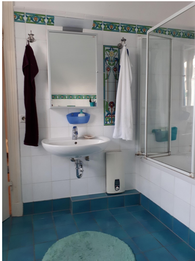
Waschbecken Durchlauferhitzer
