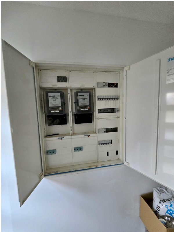
Stromkasten 2 Zähler
