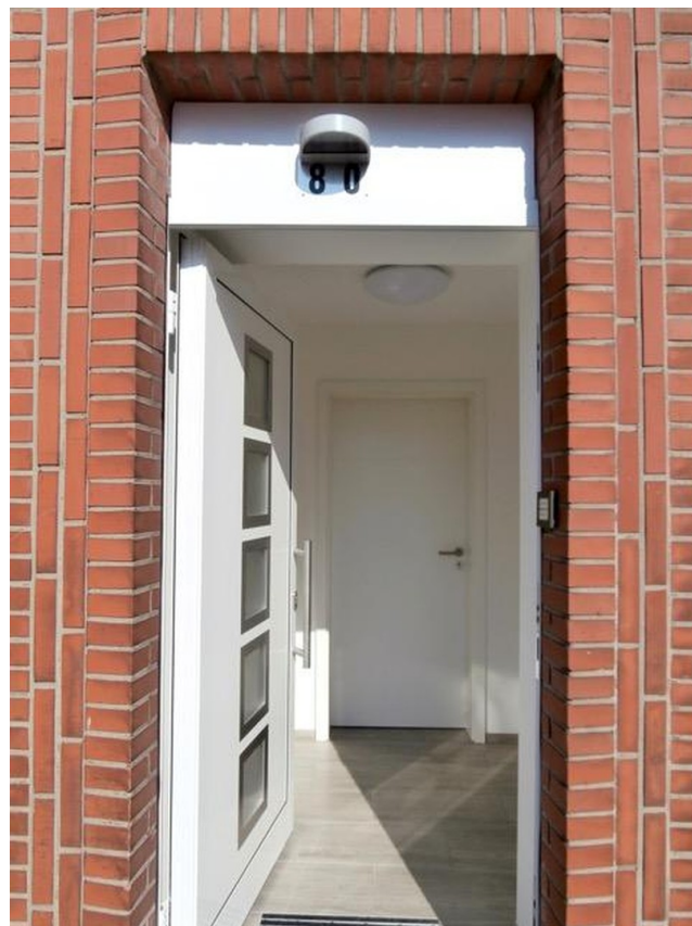
Hauseingang zum EG und OG
