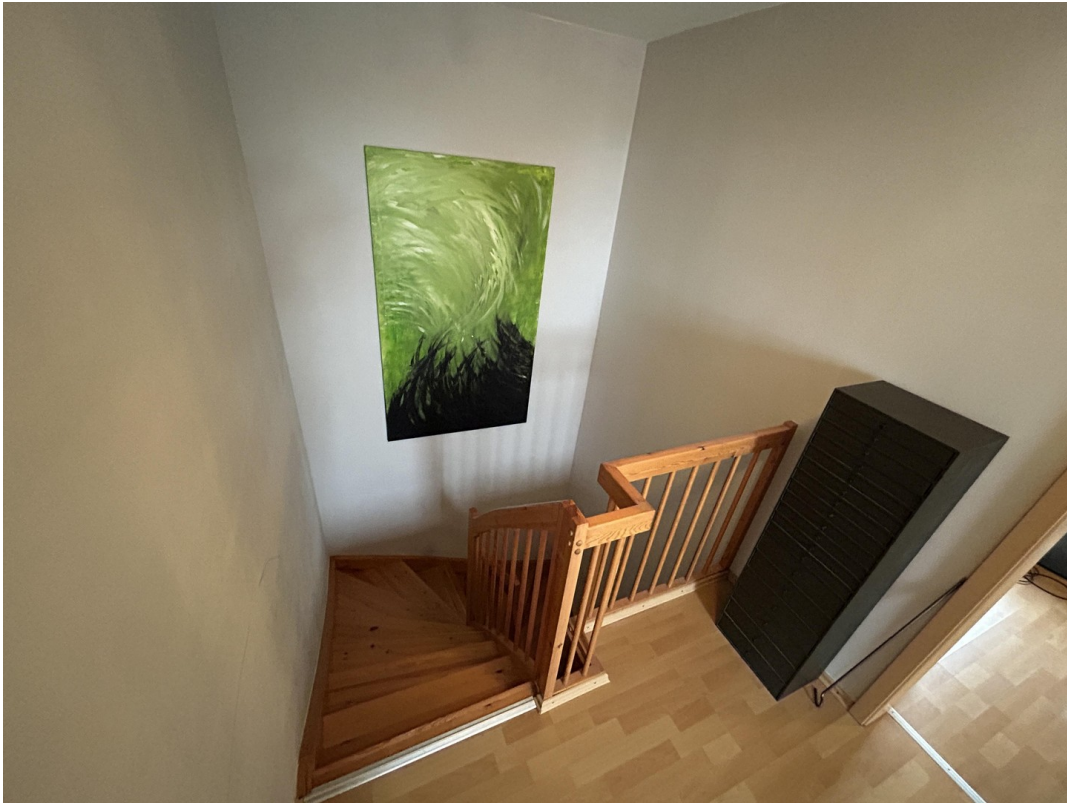
Treppe 2. OG -> 1. OG
