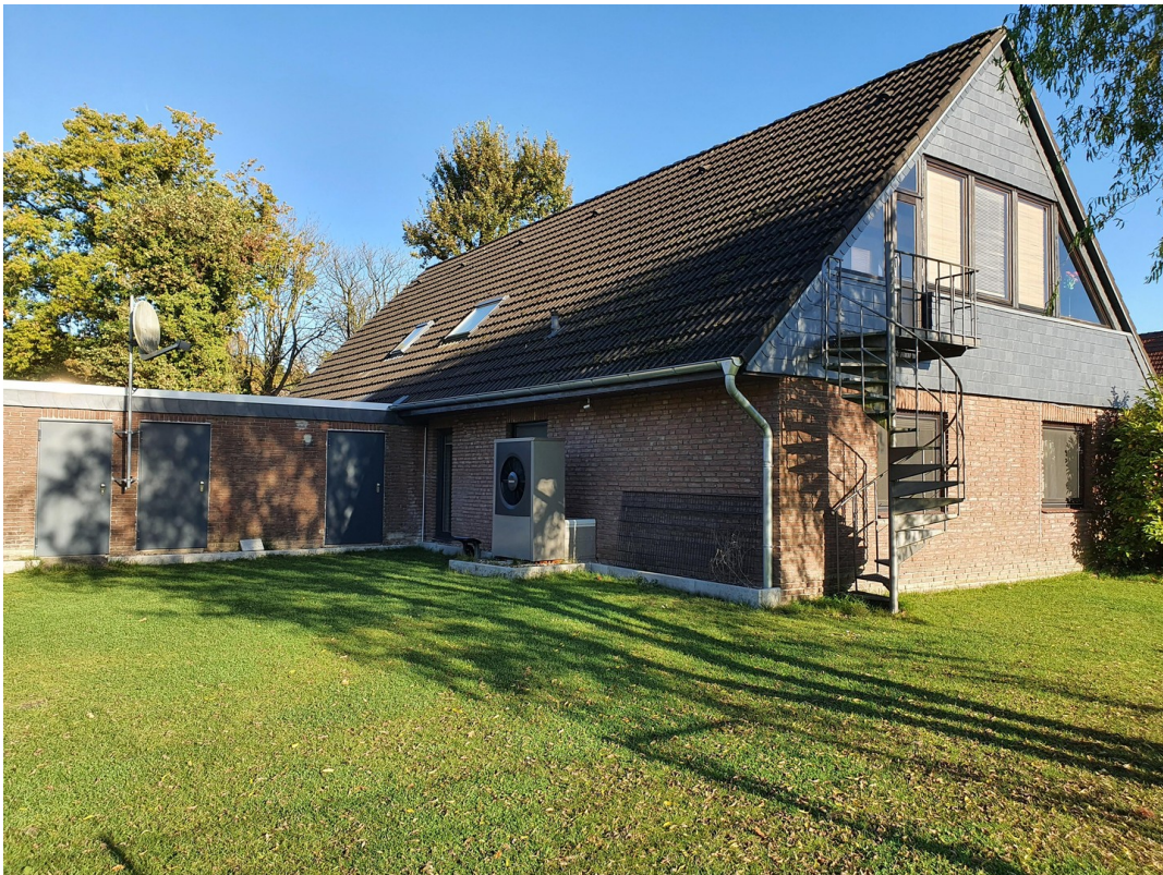
Türen Garagen + Heizungsraum
