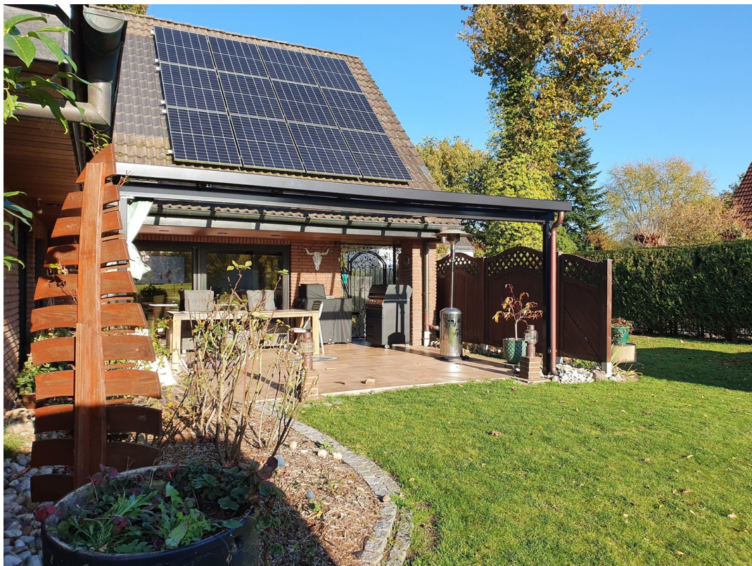
seitlicher Blick auf Terrasse
