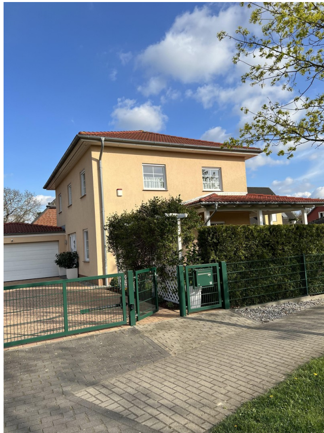
Aussenansicht mit Auffahrt
