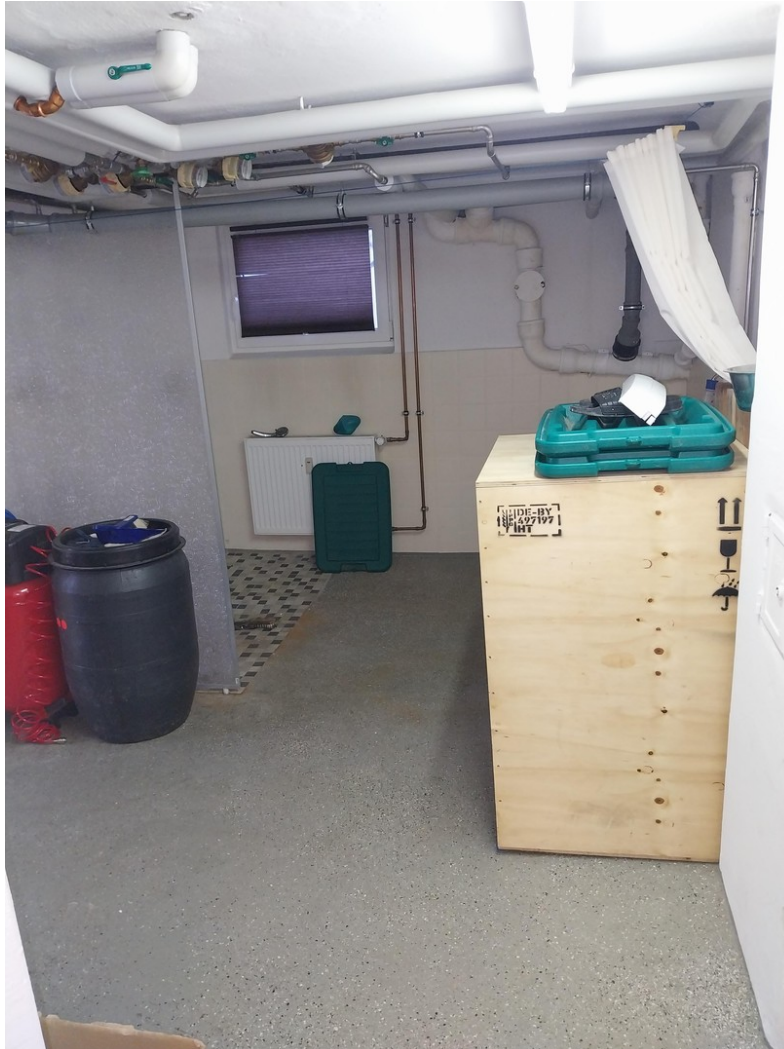
Lager mit Dusche
