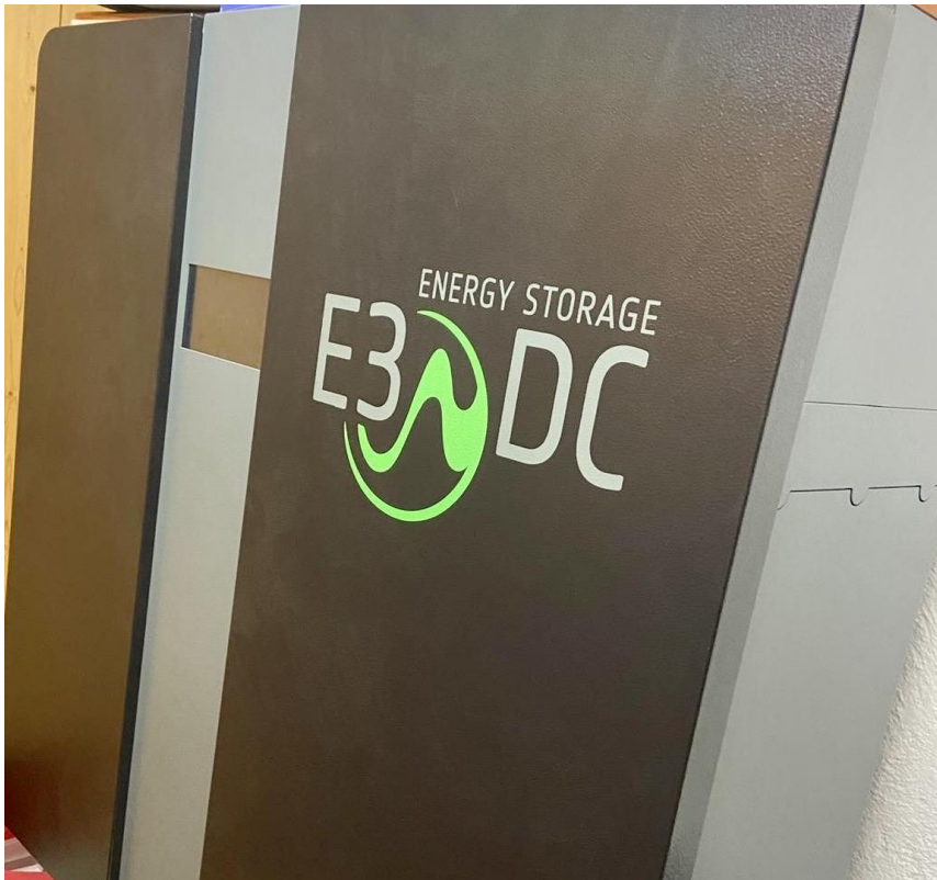
PV 10 kWh Speicher
