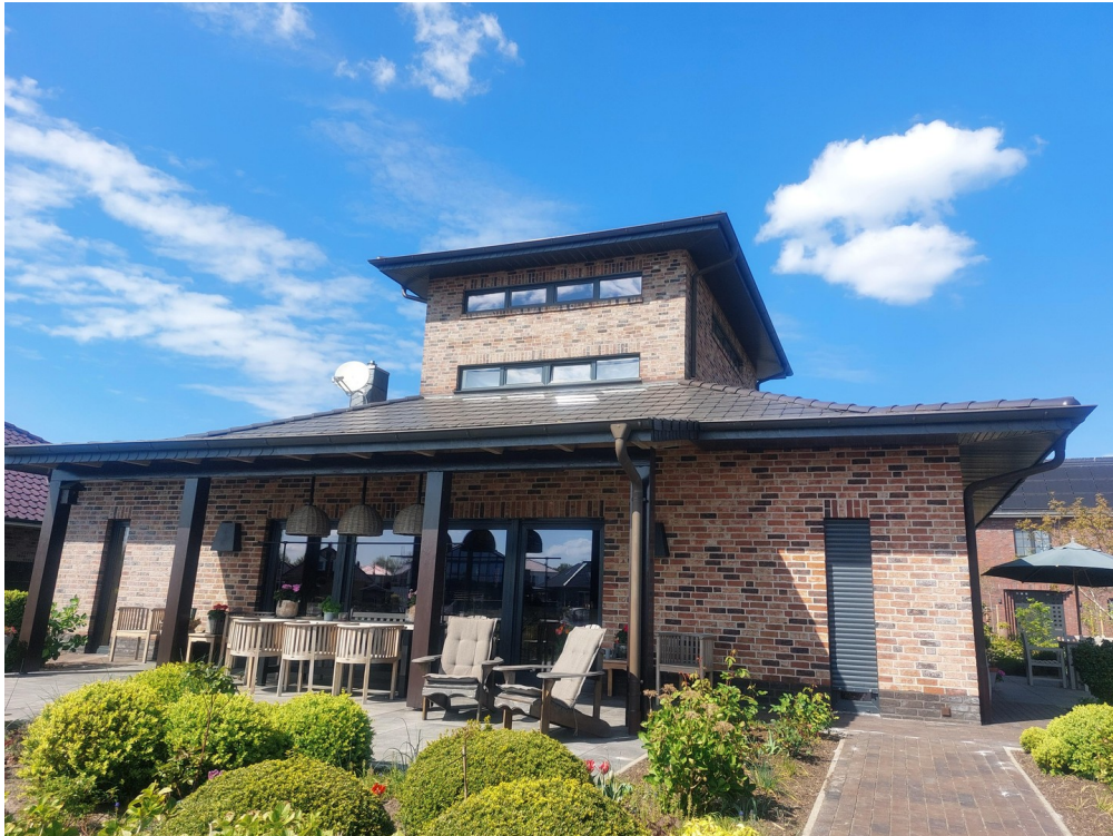
Op het zuiden
