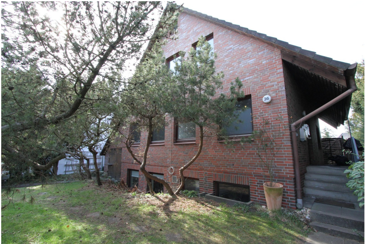
Giebelansicht NO Vorgarten
