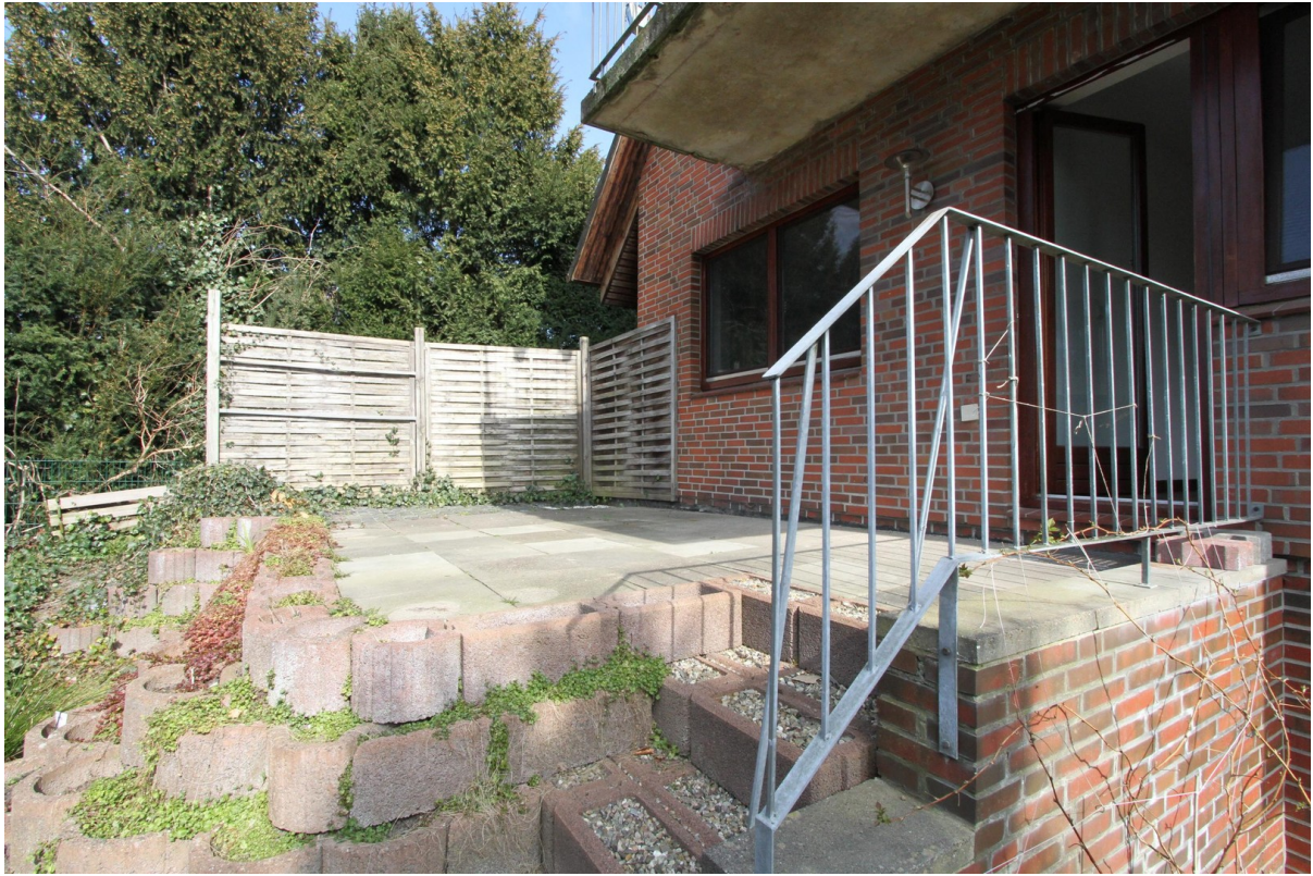
EG Gartenterrasse SW
