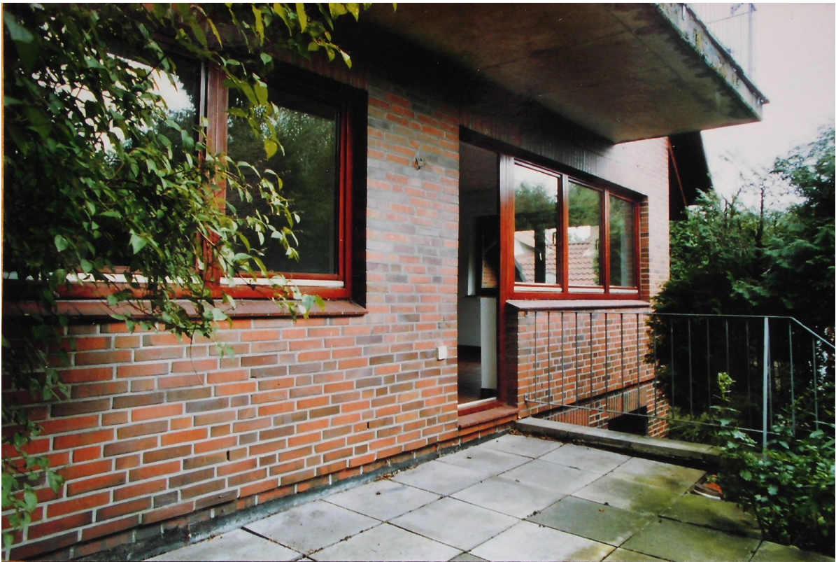
EG Gartenterrasse SW
