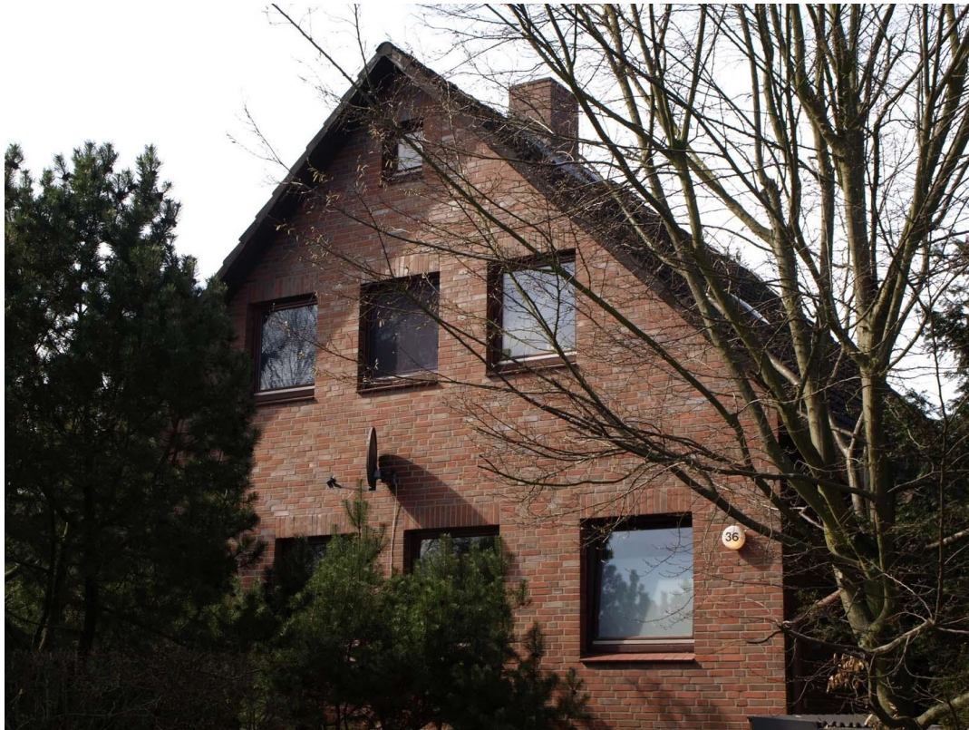
Giebelansicht NO Vorgarten
