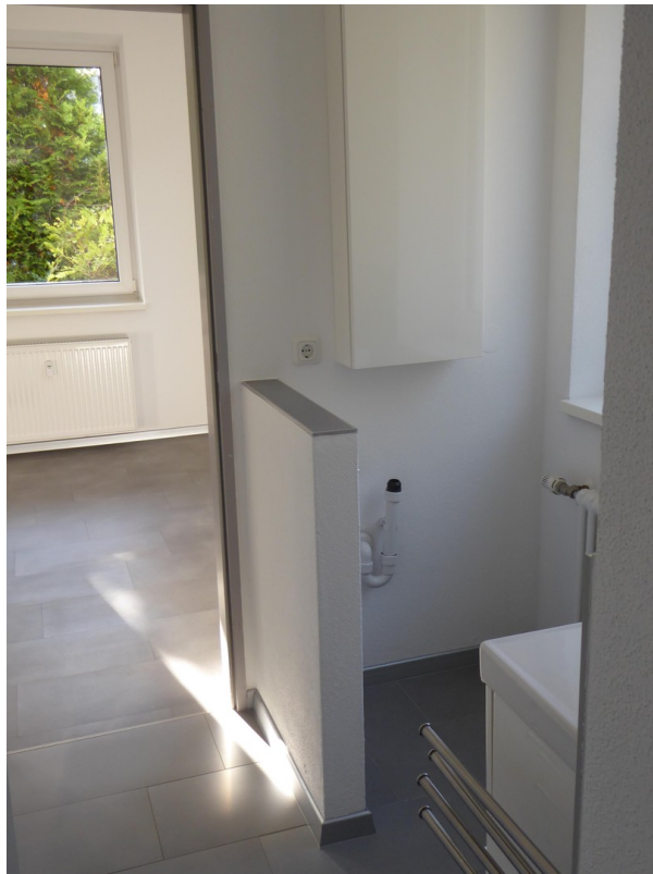
Waschmaschinenanschluss
