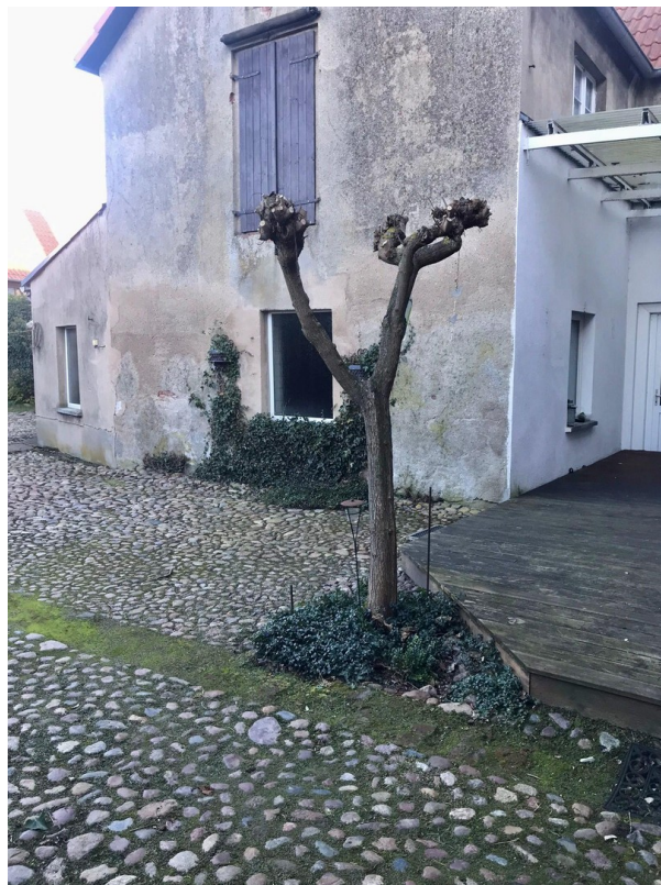
Ehem. Backhaus (Außen)
