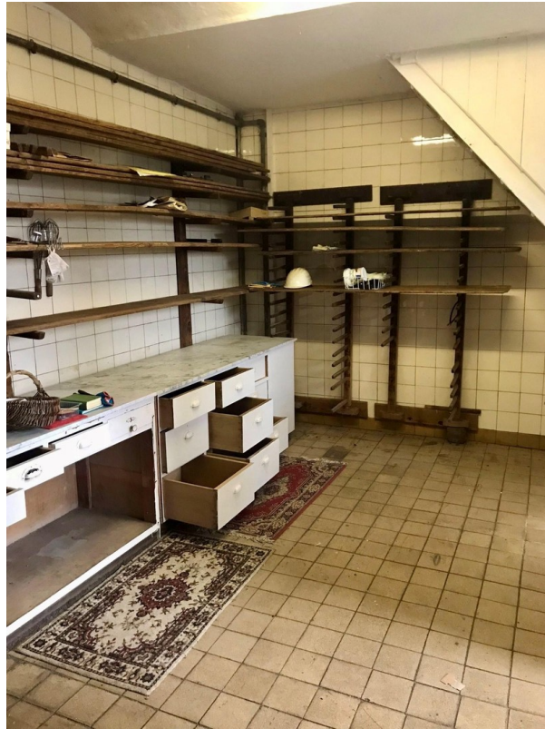
Ehem. Backhaus (Innen)
