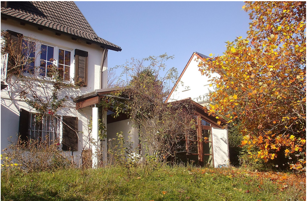
Anbau GG 1993 mit Eingang
