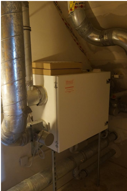
Lüftungsggerät im DG
