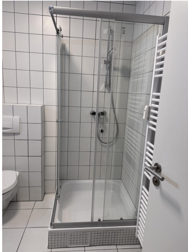
Bad: Dusche mit Handtuchhalter
