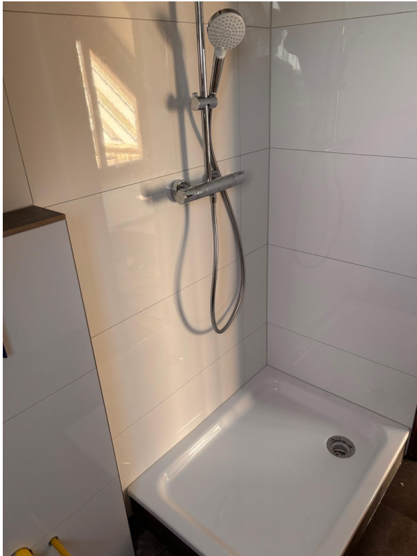
Modernisiertes Bad 2. OG
