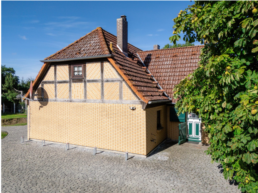
Seitenansicht mit Eingangstür
