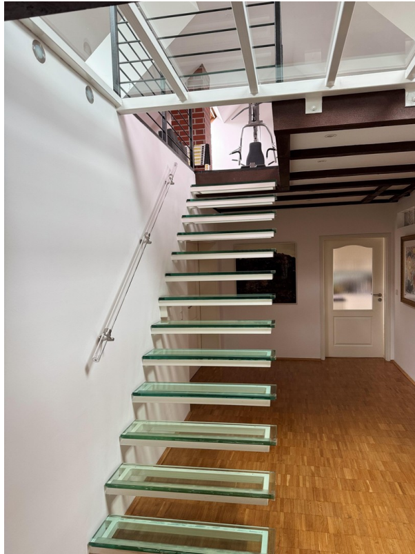
Treppe 3. ins 4. OG
