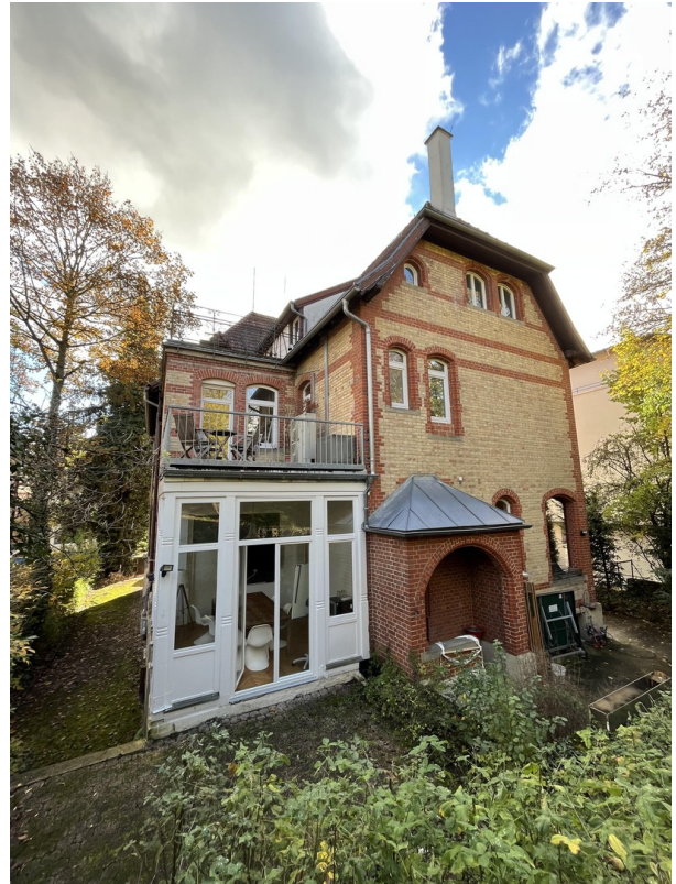
Blick vom Garten auf das Haus
