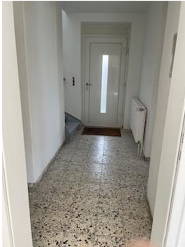
Flur wurde neu gefliest
