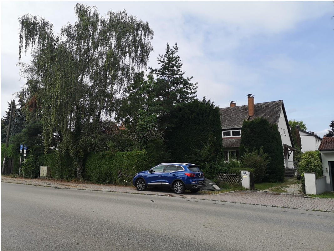
Ansicht von der Straße aus
