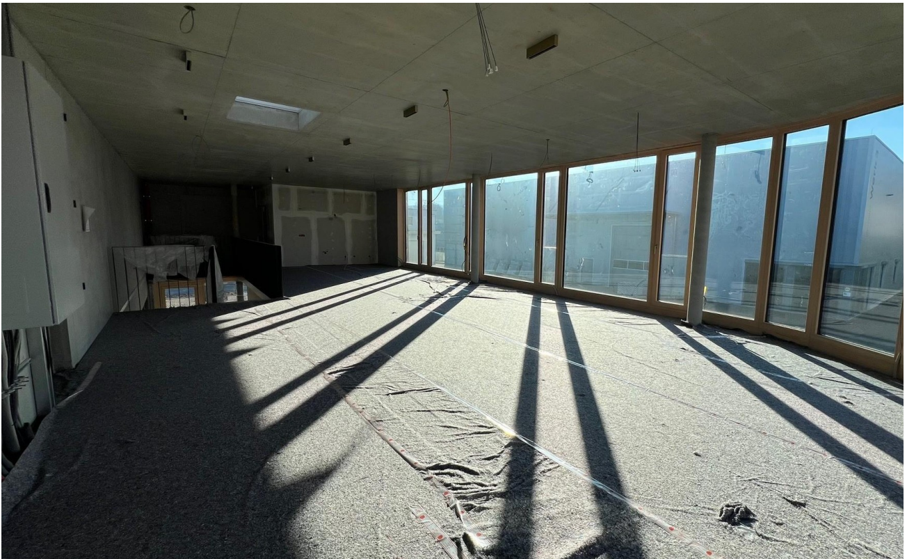
Büro OG-Boden abgedeckt
