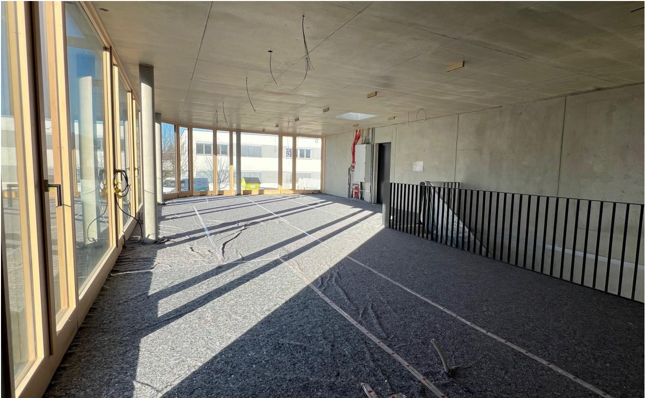
Büro OG-Boden abgedeckt
