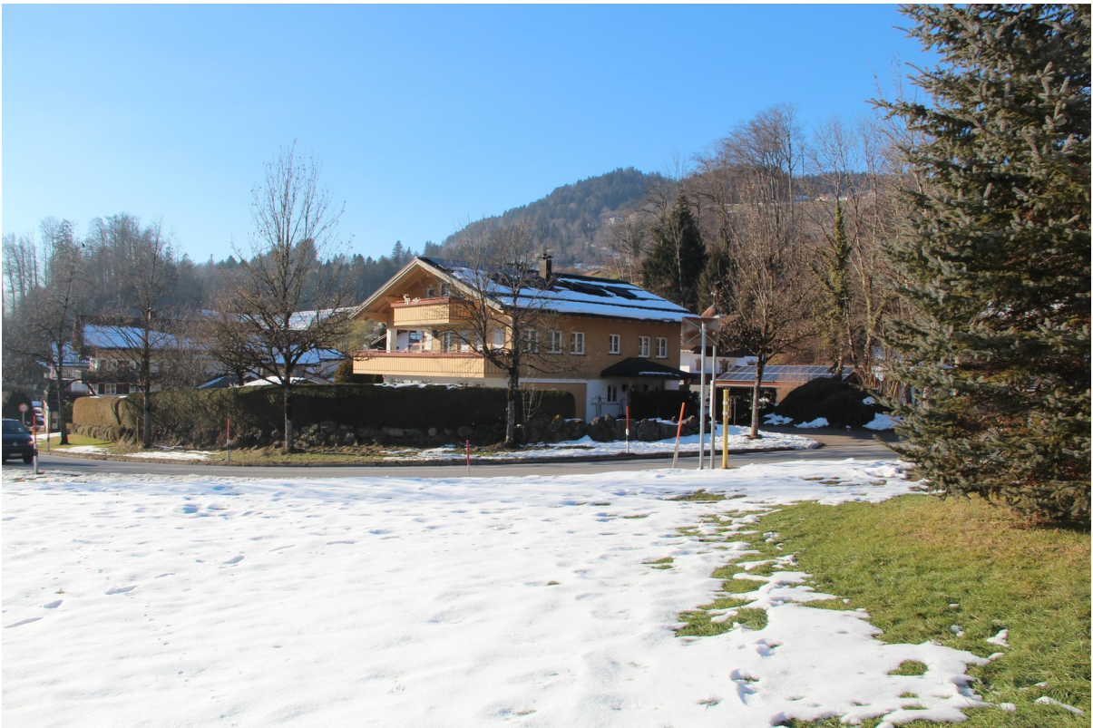
Blick vom Osten auf das Haus
