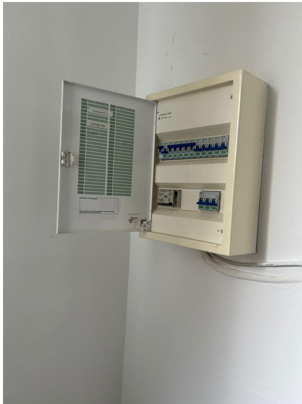
Stromverteilerkasten
