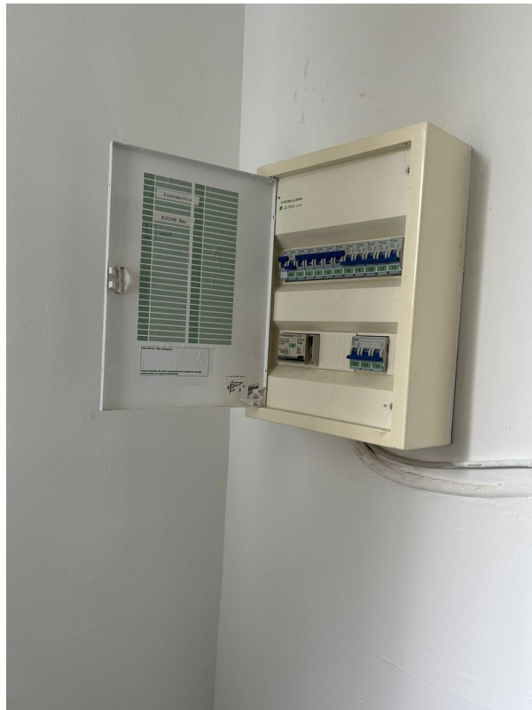
Stromverteilerkasten
