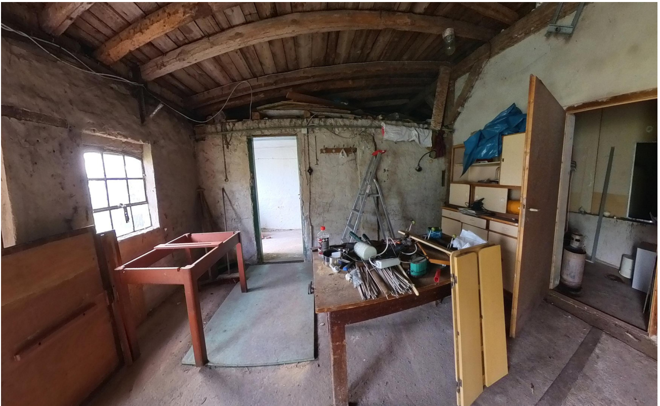
Anbau zum Haus & Heizungsraum
