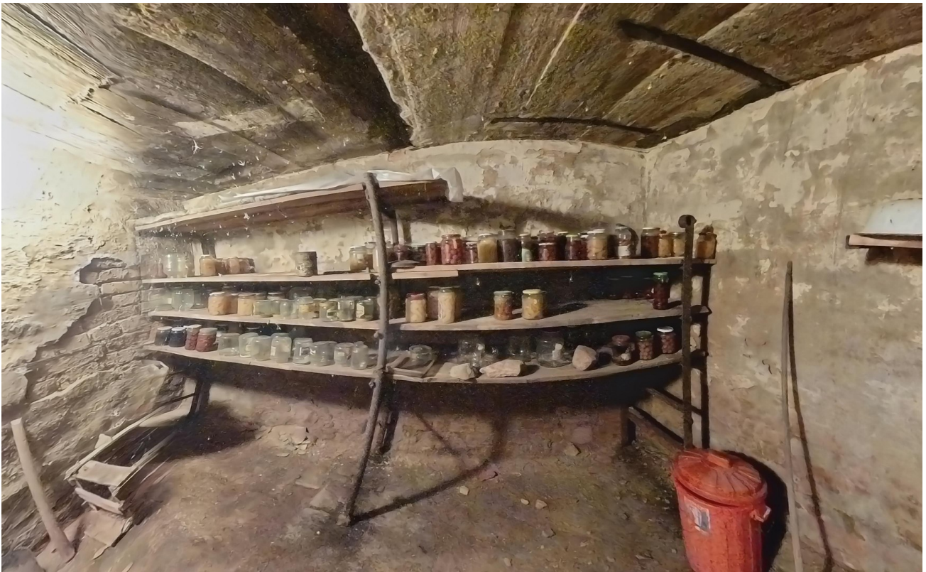
Keller im Anbau
