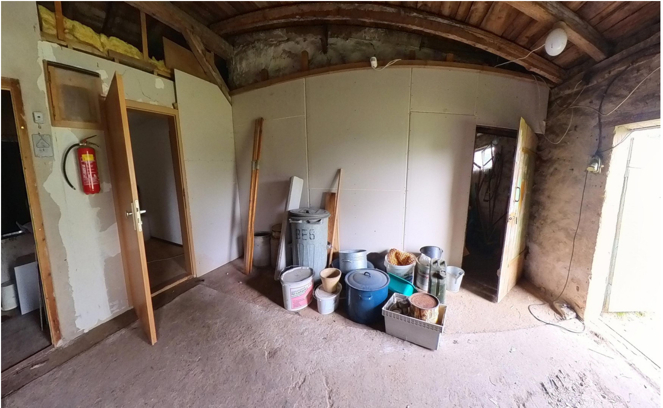
Anbau zum Holzlager und Büro
