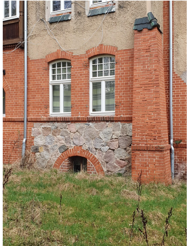
Detail der Südansicht
