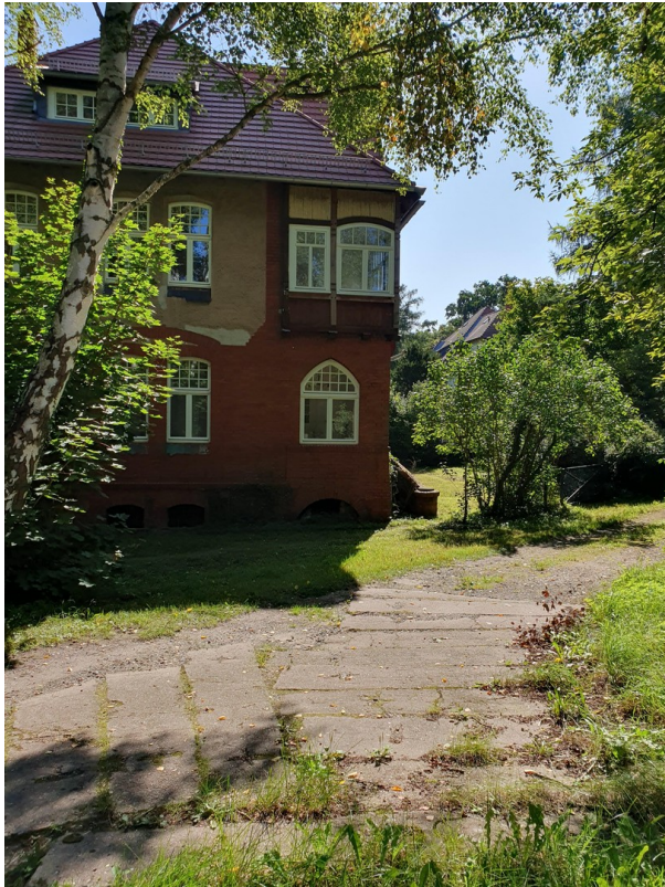
Weg mit Westseite
