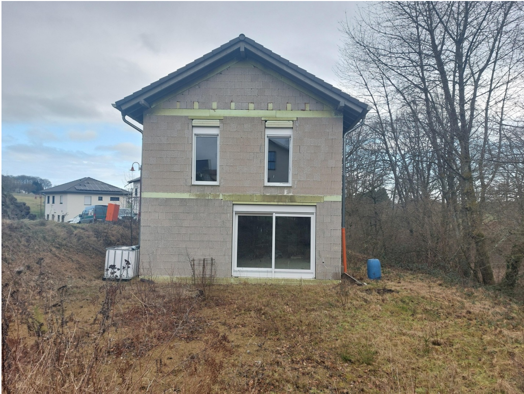
Westen des Hauses obere SR
