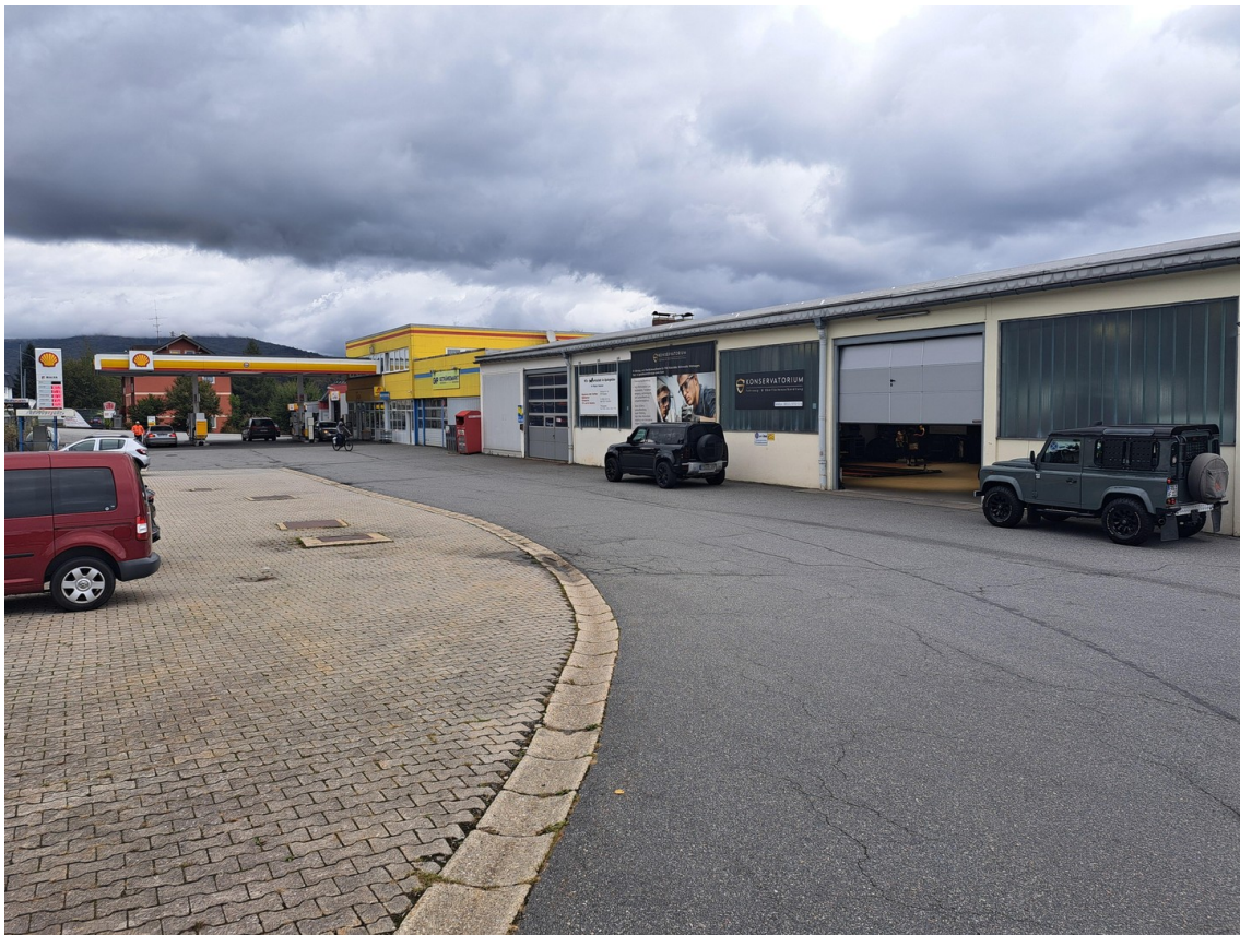
Gebäude Seite Hauptstraße
