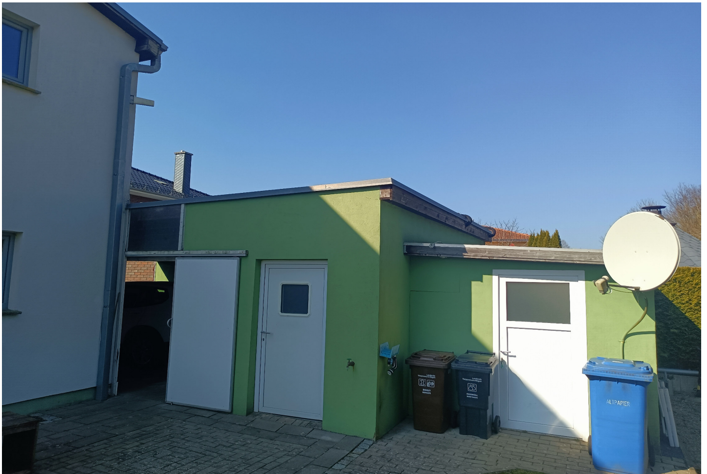
Hintere Ansicht mit Schuppen massiv
