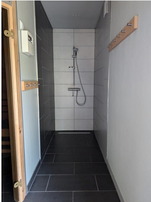
Dusche im Saunabereich
