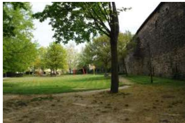
Stadtmauer am Lahntorpark
