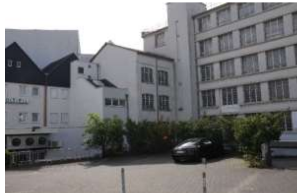
Ehemalig Schuhfabrik (um 1930 entstanden)
