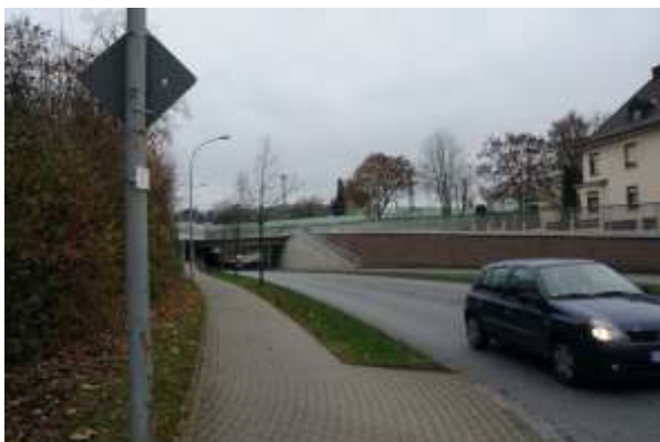
Unterführung B3 bei Hallenbad
