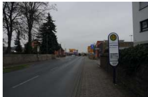
Griedeler Straße Blick Richtung Kreisell
