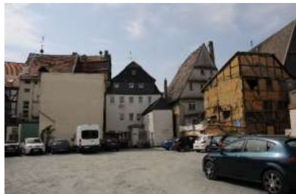
Schotterparkplatz hinter Gasthaus Werb
