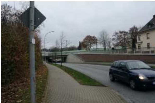
Unterführung B3 bei Hallenbad
