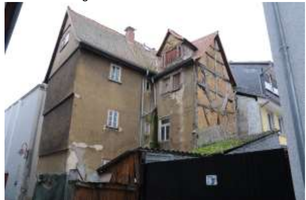
Mehrfamilienhaus Guldengasse - Quergasse
