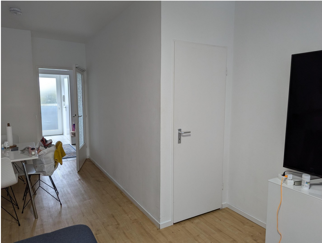
Kammer unter der Treppe
