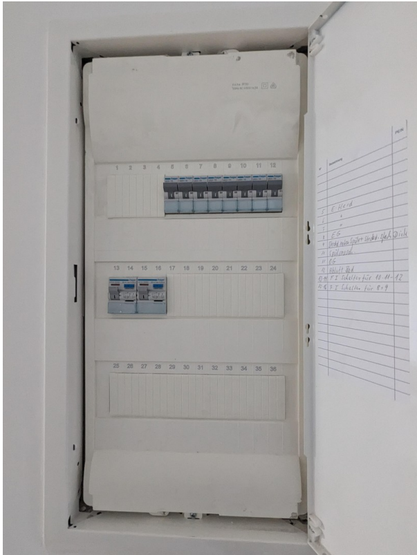
Sicherungskasten
