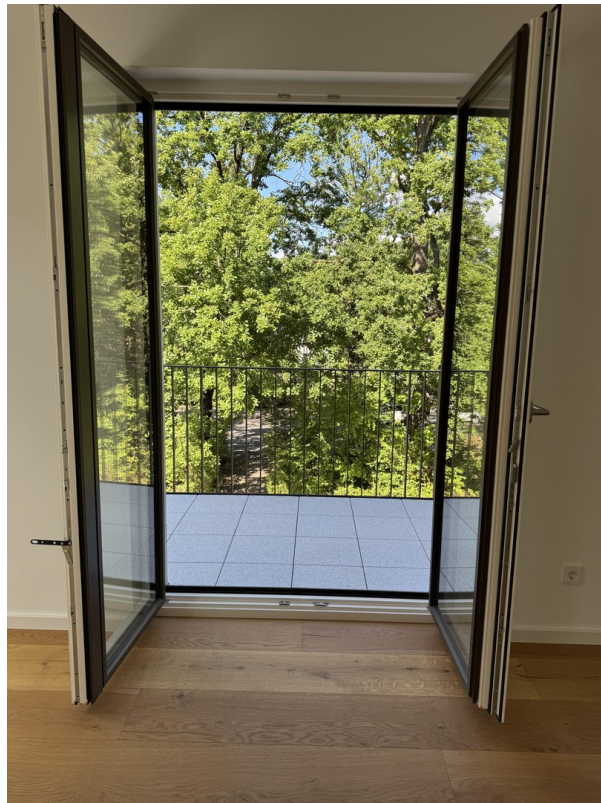
Balkon zur Straße
