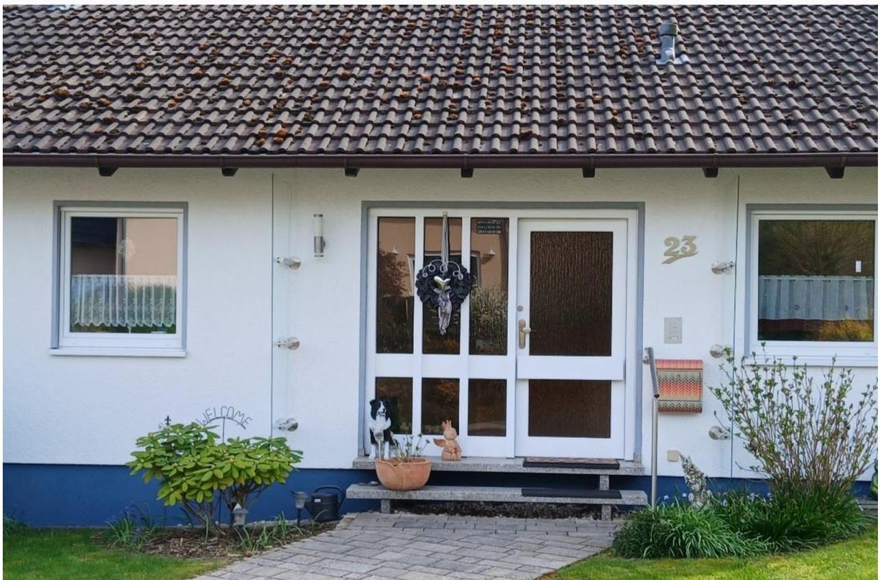
Haustüre mit hochwert. Windfang
