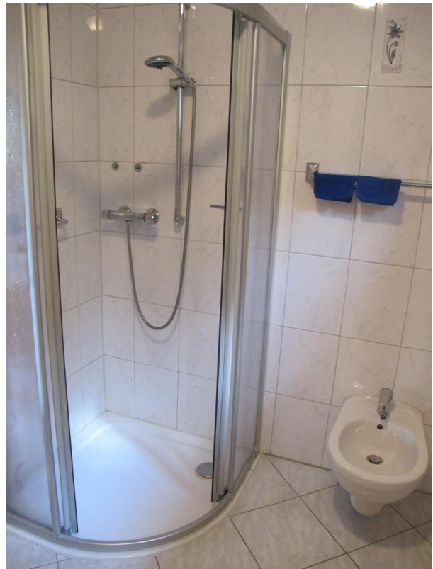
Dusche neu installiert
