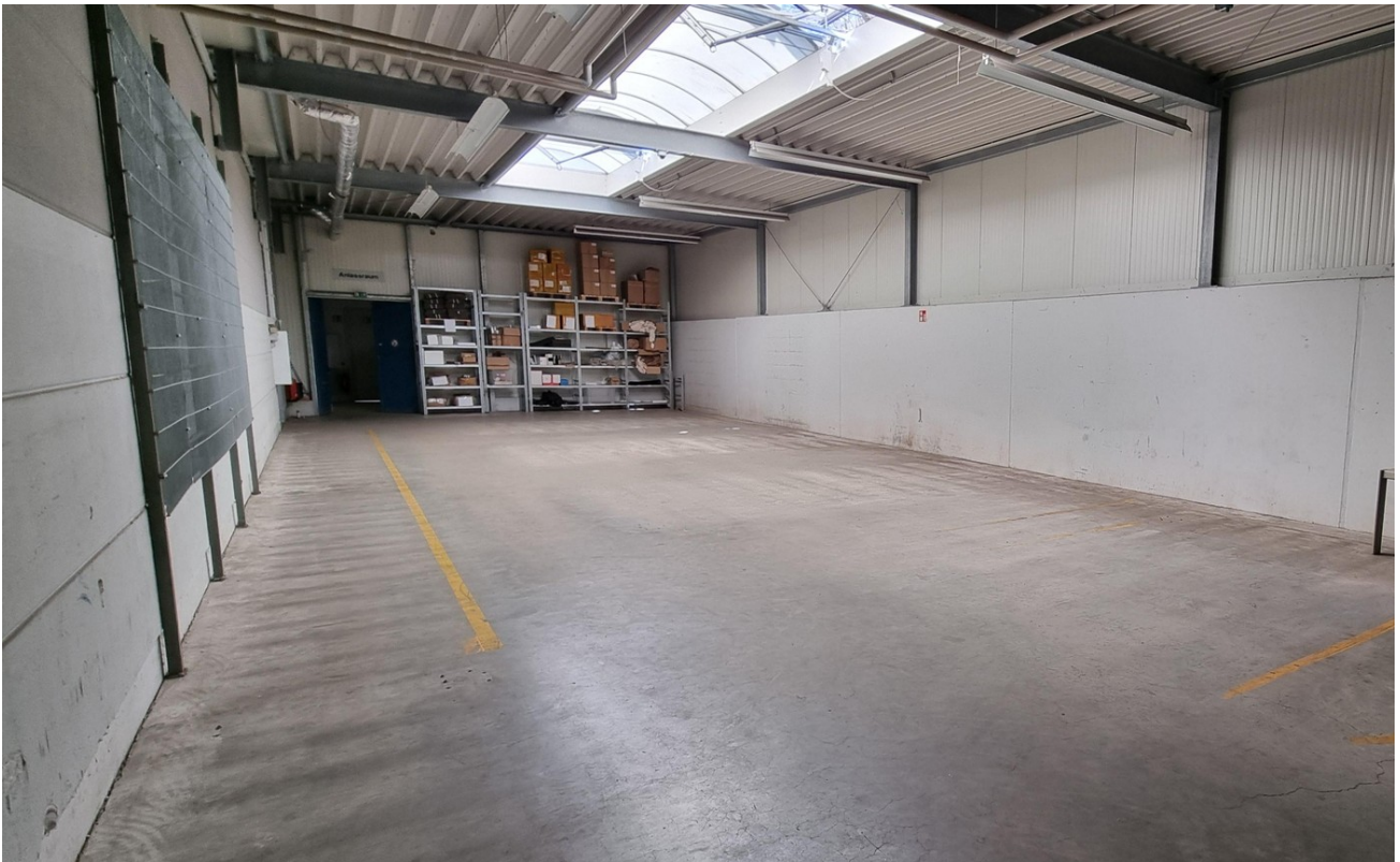
Anbau 1 (Mitte hinten)
