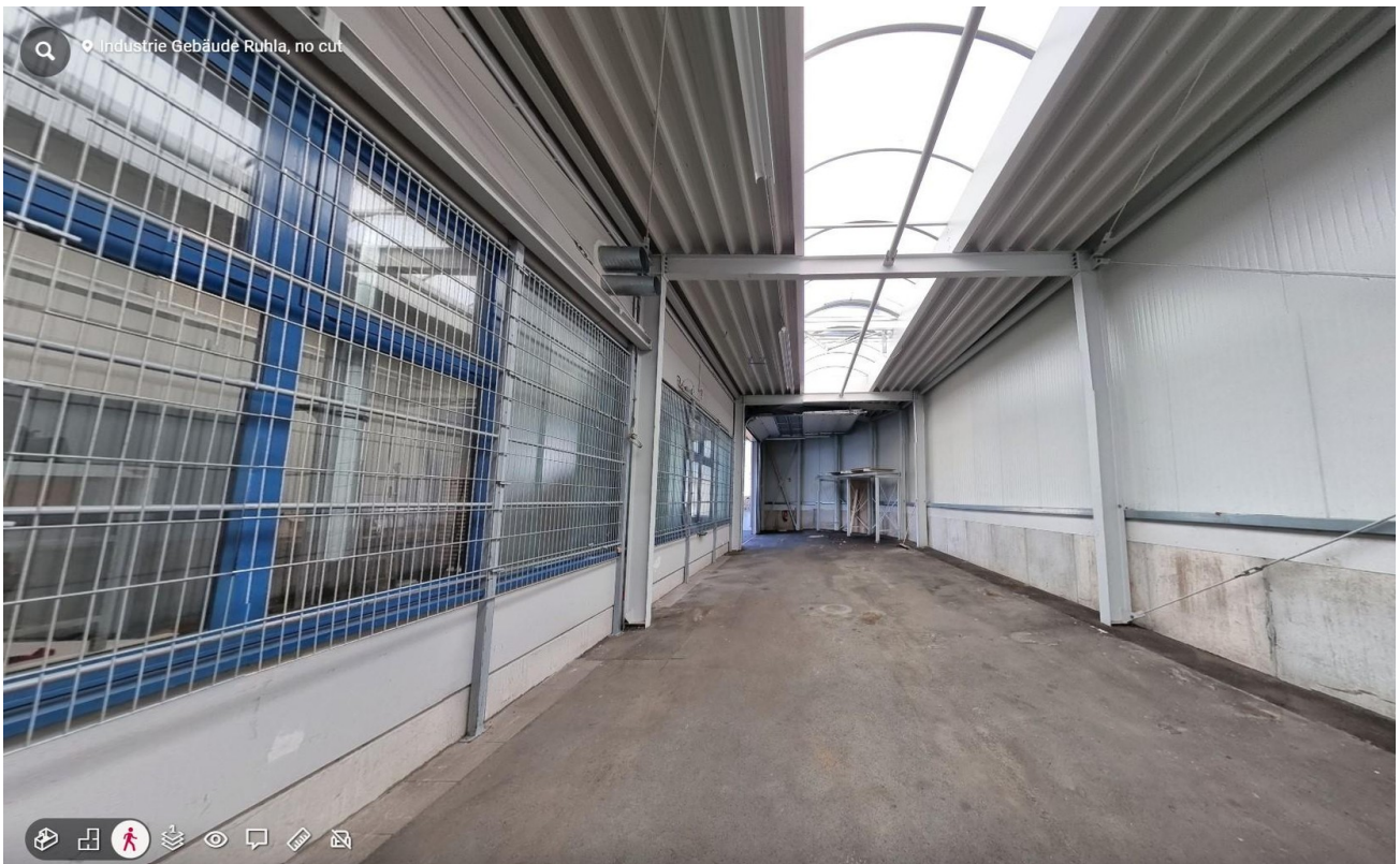
Anbau 3 (Links hinten)
