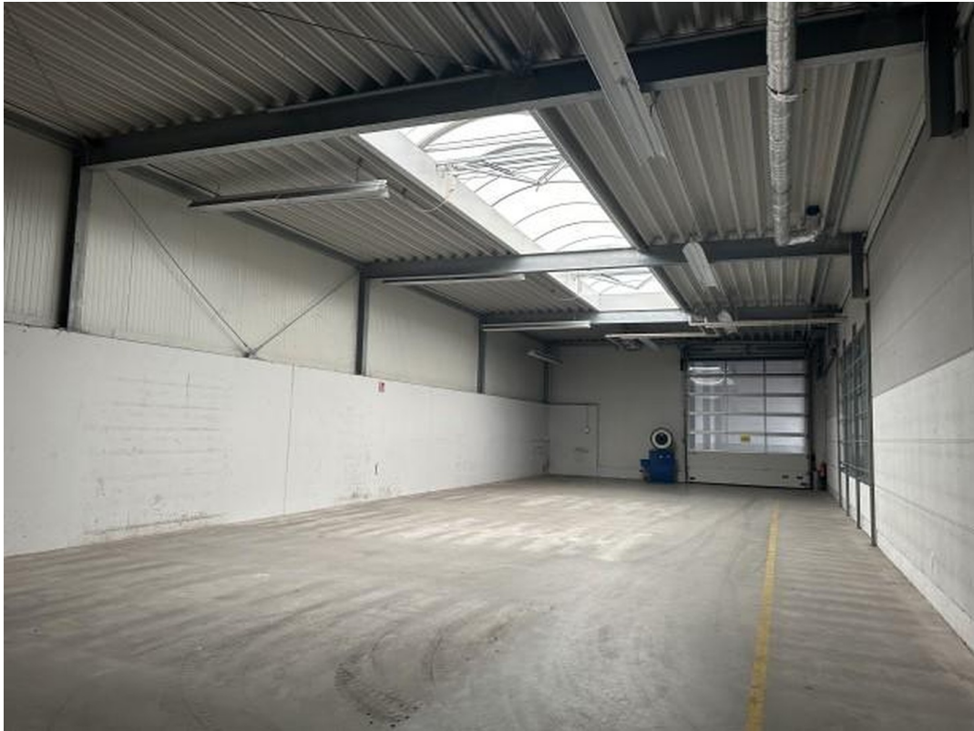
Anbau 1 (Mitte hinten)
