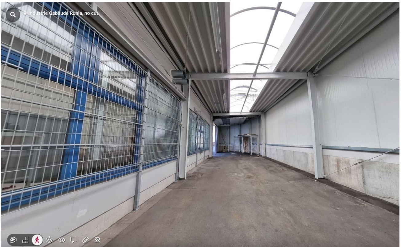
Anbau 3 (Links hinten)
