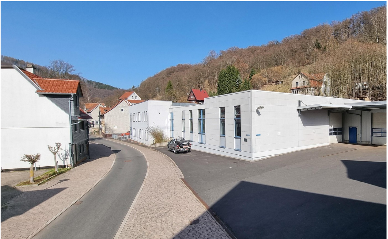
Außenansicht Ladezone 1 von 2
