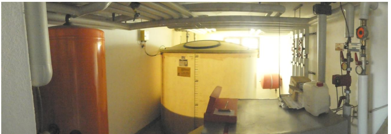
Abbildung 21 Heizraum mit Öltank
