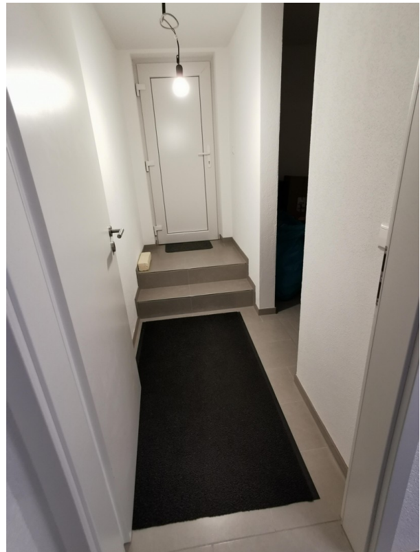
Zugang Garage - Keller
