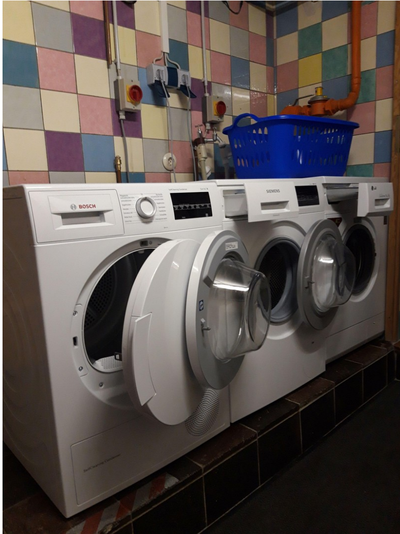
Waschküche im Keller
