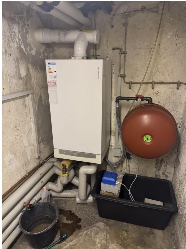
Gas Brennwertheizung
