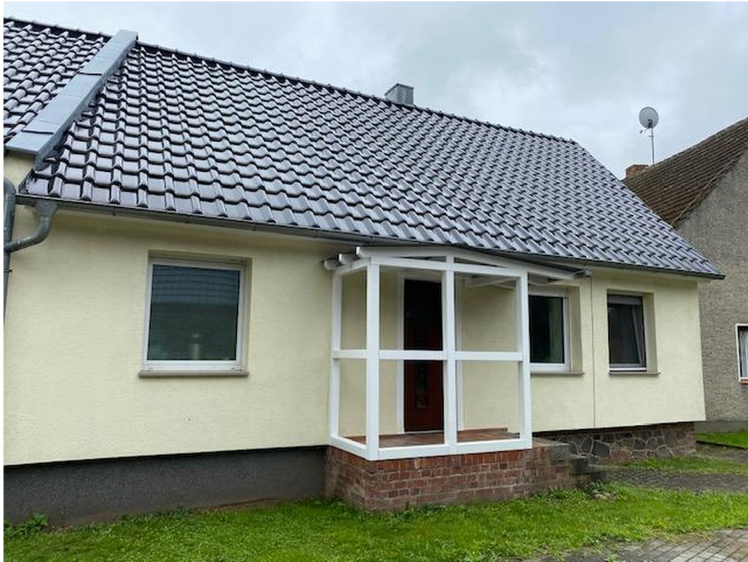
Eingang mit Parkplatz
