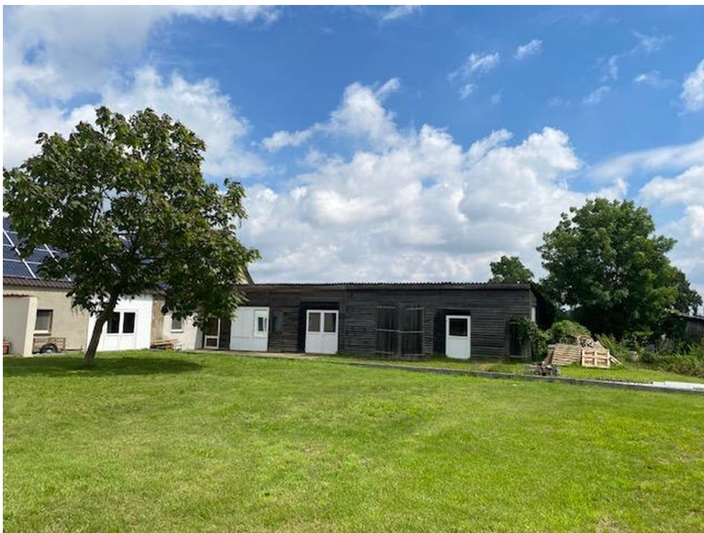
Blick vom Backhaus
