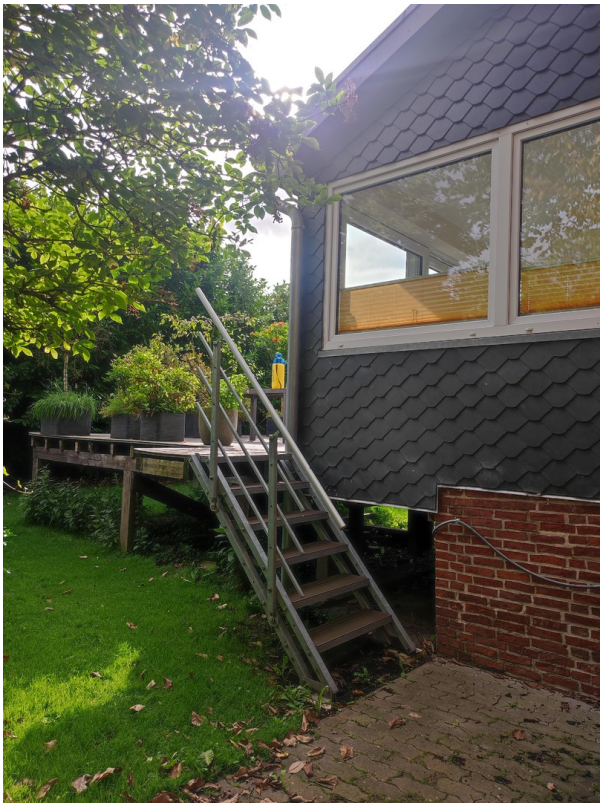
Treppe zur Terasse
