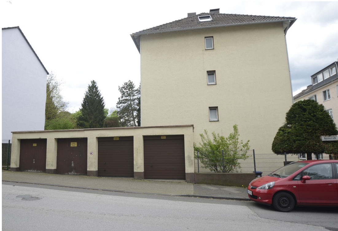
Seitenansicht mit Garagen
