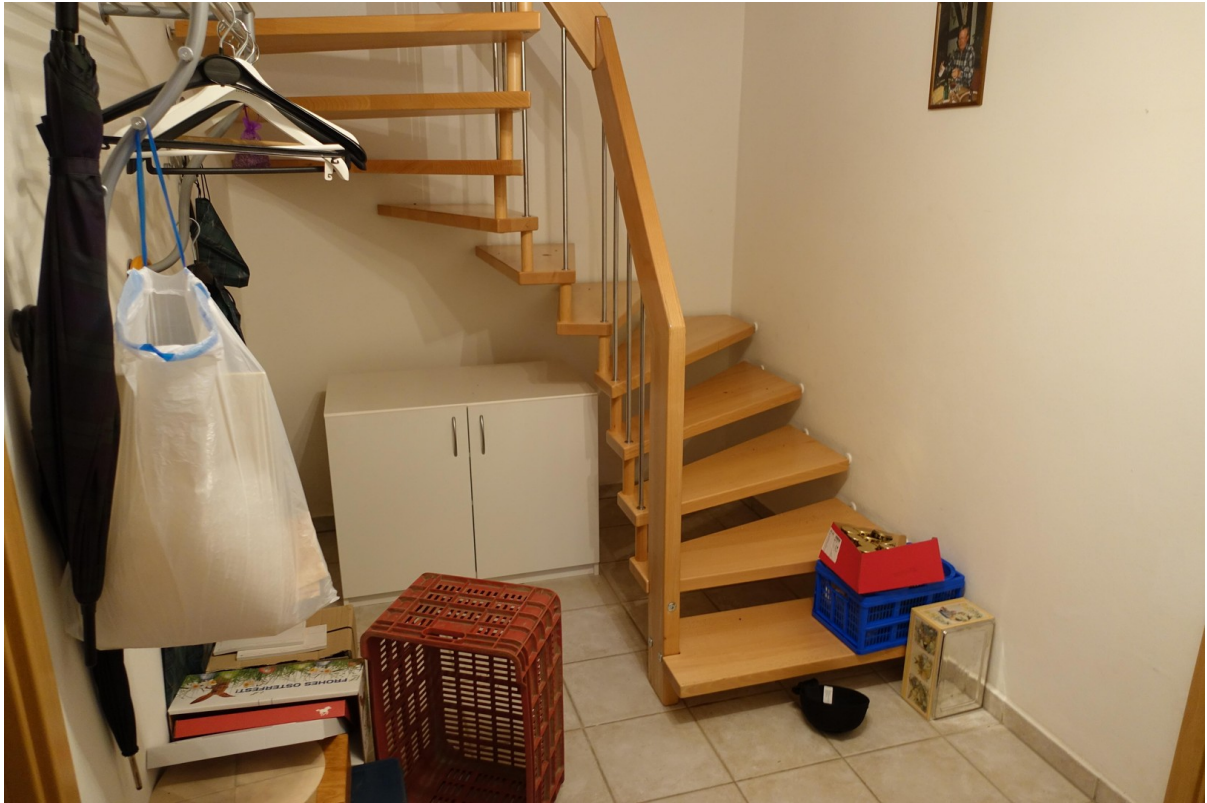
Treppe in Keller
