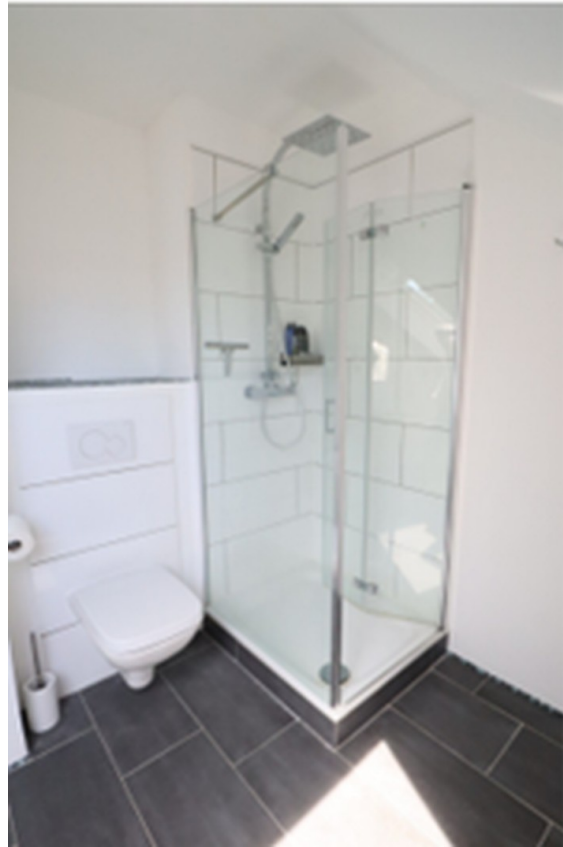
Bad OG Dusche
