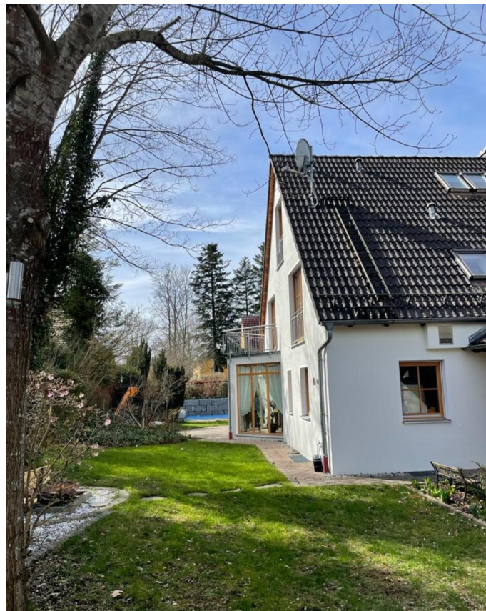
Haus östliche Ansicht
